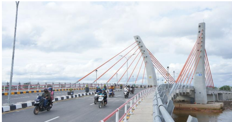
Jembatan Sei Alalak, Banjarmasin
