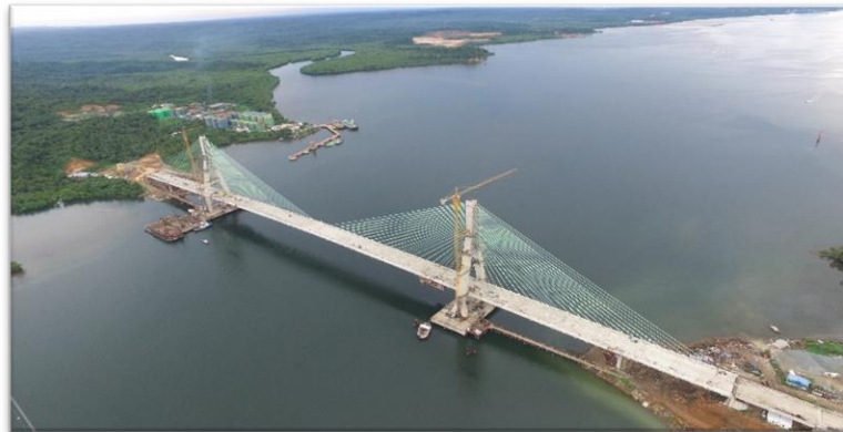
Jembatan Pulau Balang, Balikpapan
