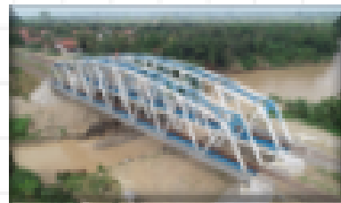
Jembatan Kereta Luluko, Kutoarjo, Jawa Tengah
