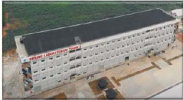
Gedung Laboratorium Teknik 2, Institut Teknologi Sumatera, Lampung
